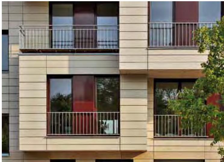
Die Abweichung der Fassadenerker vom günstigen A/V-Verhältnis wurde vorab mittels PHPP auf ihre Darstellbarkeit im Energiekonzept geprüft
