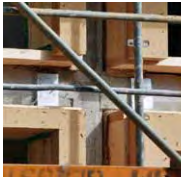
Nach der Montage wurden die Fassadenelemente nochmals überdämmt
