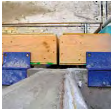
Die hochgedämmten Holztafeln wurden in den Betonbau eingehängt
