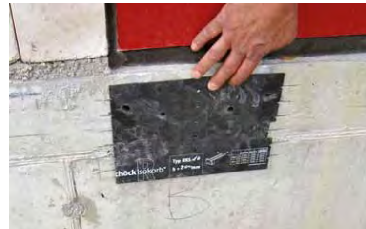
Abb. 1: Nachdem die richtige Position für den Anschluss ermittelt wurde, werden die Bohrlöcher mithilfe einer Schablone angezeichnet
