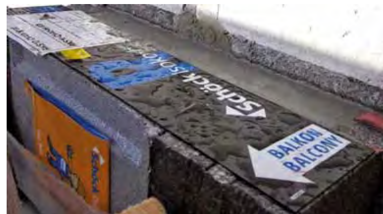
Abb. 8: Im letzten Schritt wird die Vergusstasche mit Spezialmörtel verfüllt, um die Druckzone des Anschlusses kraftschlüssig mit der Decke zu verbinden
