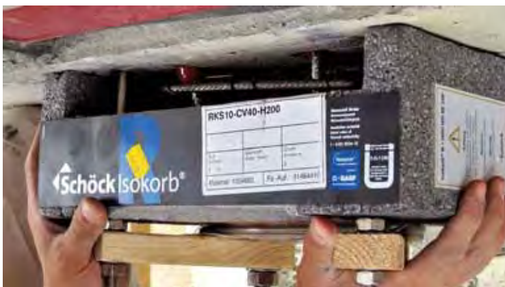
Abb. 7: Das Injektionsmaterial muss nun aushärten. Hier ist die Vergusstasche zu sehen, die im nächsten Schritt verfüllt wird
