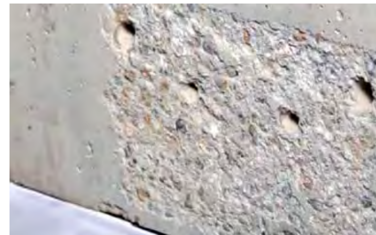
Abb. 3: Die Stirnfläche der Bestandsdecke wird komplett aufgeraut, um den Verbund zu gewährleisten
