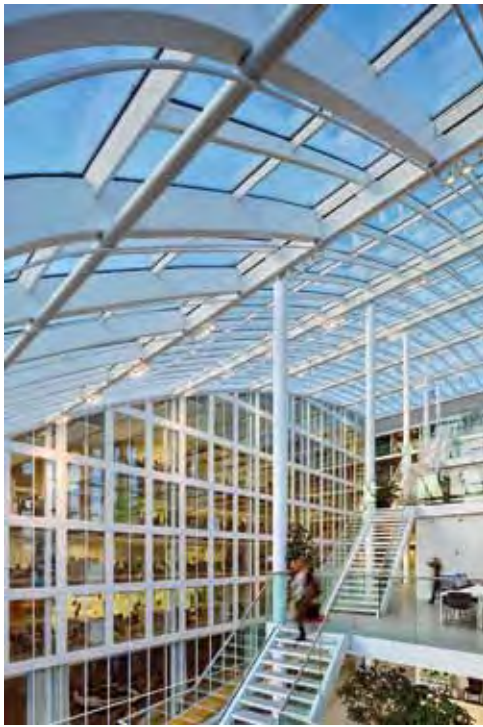
Die Tragstruktur lässt sich in Bezug auf Effizienz und Einfachheit mit der eines Gewächshauses vergleichen
