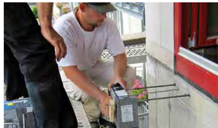
Abb. 6: Der Isokorb R wird von außen in die Bestandsdecke eingeschoben
