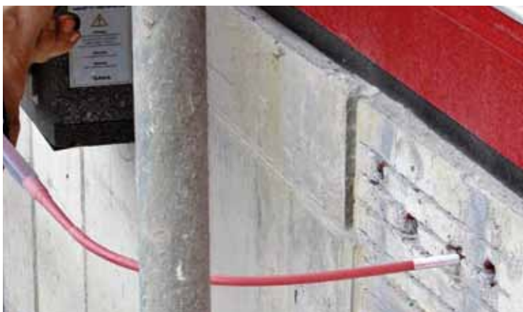
Abb. 5: Die Bohrlöcher werden mit Injektionsmaterial gefüllt
