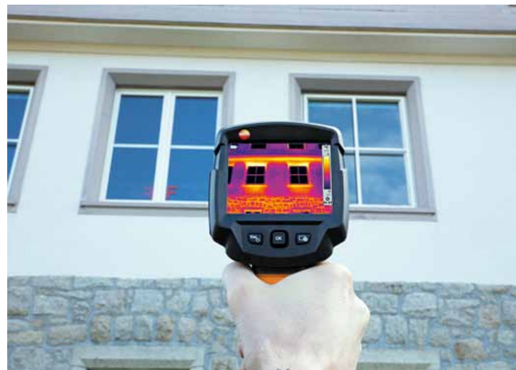
Thermografiekameras orten Wärmebrücken, zugige Fenster, Ausführungsmängel oder Leckagen
