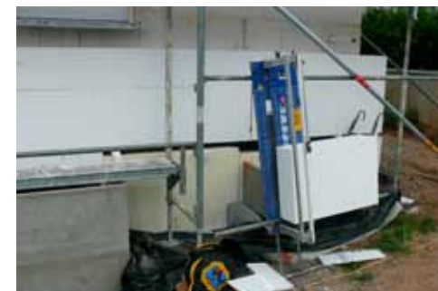
Verschnitt bei der Montage von Wärmedämm-Verbundsystemen
