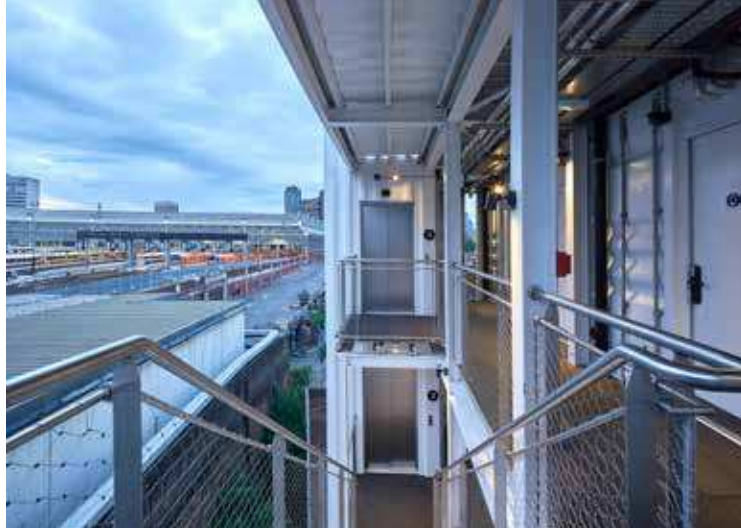
Foto: Edmund Summer 30-Fuß-Schiffscontainer sind hier, übereinander und nebeneinander gestellt, ein Hotel, das die Anforderungen nach Einfachheit, Robustheit und Flexibilität erfüllt
