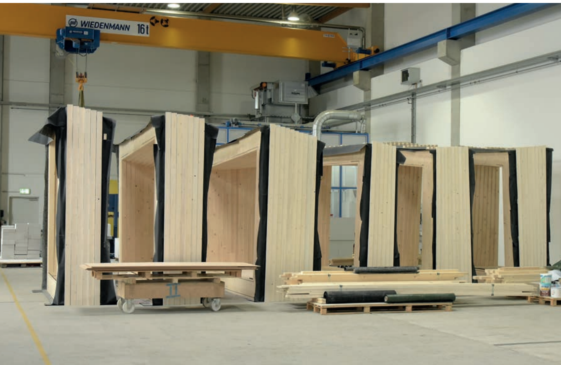
Vorgefertigte Baumodule in der Konstruktionshalle bei Ackermann GmbH in Wiesenbronn.
