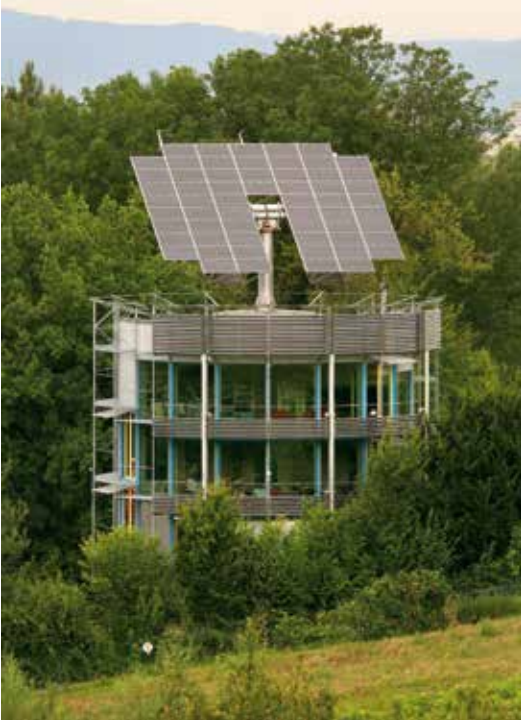
Foto: Rolf Disch SolarArchitektur, Freiburg
