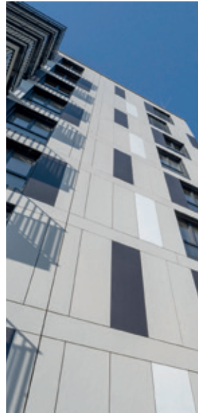
Referenzobjekt Weißenhurm: Fassadentafeln Hardie® Panel in Schneeweiß
