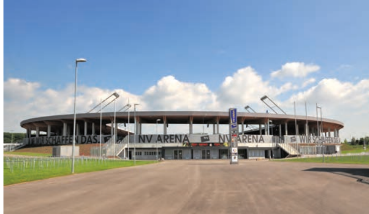
Fotos: Alpine Bau GmbH, Wals-Siezenheim
