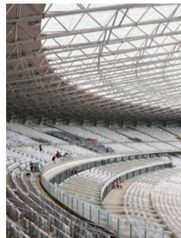
Das bestehende Kragdach wurde verstärkt und mit einer ringseilartigen Konstruktion nach innen verlängert
