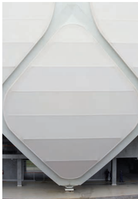
Ein einzelnes Fassadenmodul. Der rautenförmige Stahlrahmen sind mit einer PTFE-Membran ausgefacht
