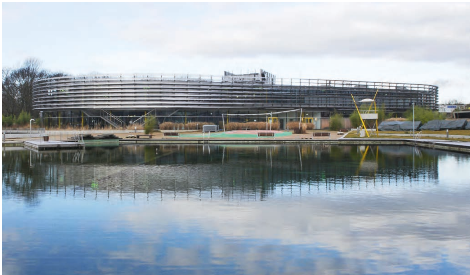
Blick von Westen über den Freibadbereich hinweg auf das Stadion
