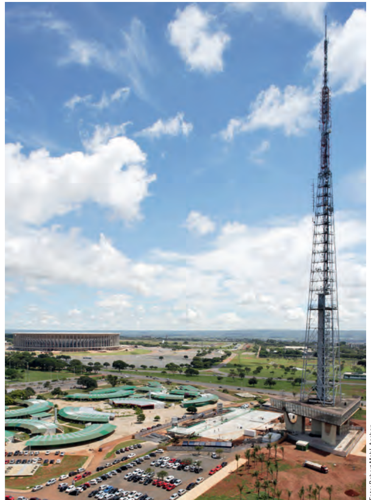
Das Nationalstadion steht unmittelbar an der zentralen Eixo Monumental. Im Vordergrund dessen breiter Mittelstreifen mit dem Fernsehturm und dem permanenten Wochenmarkt
