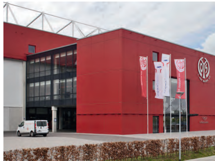
Der Haupteingang mit der Businessbrücke
