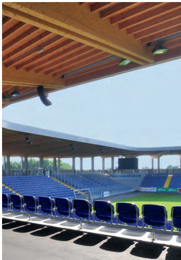
Foto: Alpine Bau GmbH, Wals-Siezenheim
