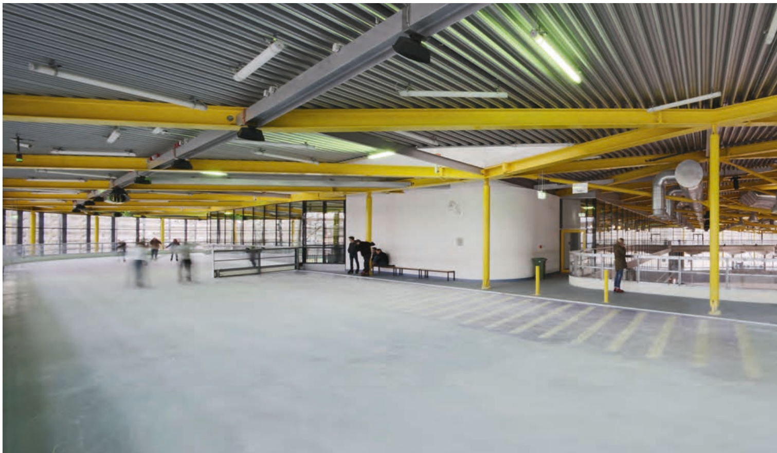
Der Zugang zur Eishochbahn. Rechts im Bild der thermisch offene Übergang zur tiefer liegenden Turniereisfläche
