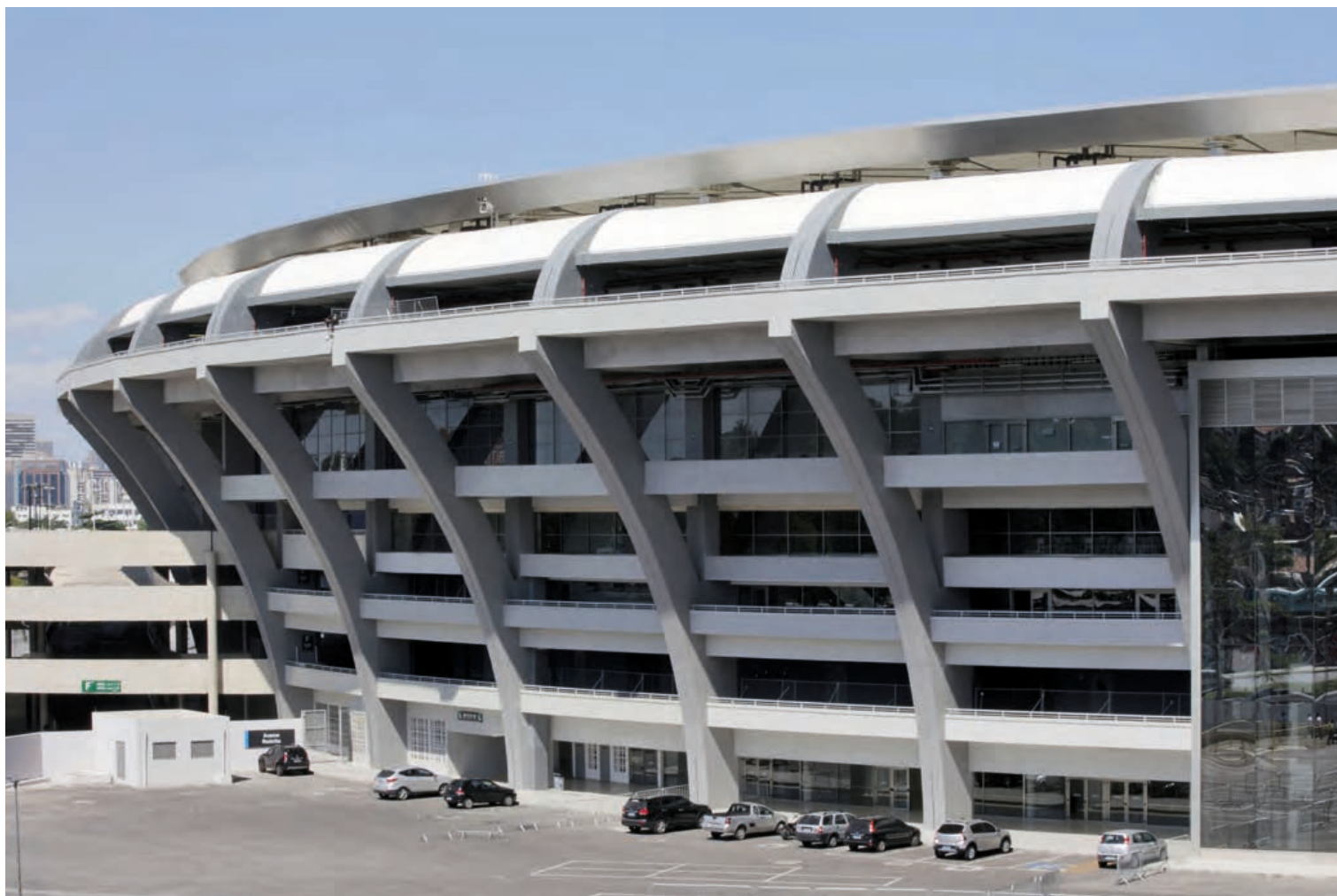
Dort wo früher einmal das alte Kragdach anschloss, liegt nun der nur etwa 1 m hohe stählerne Druckring der neuen Dachkonstruktion auf
