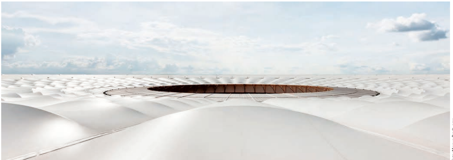
Mit einer PTFE-Membran wurde die Ringseilkonstruktion segelartig belegt.
