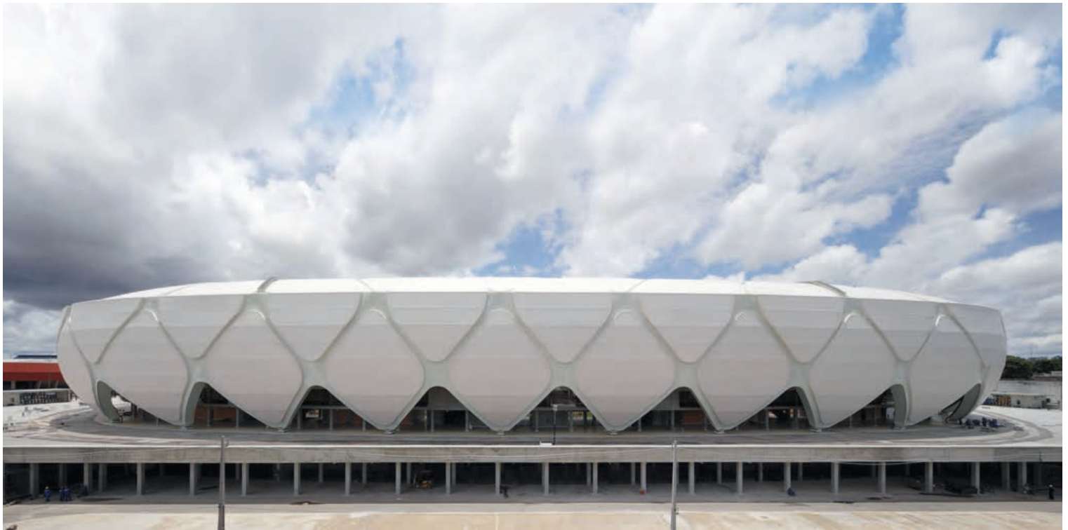
Die Stadionfassade, bestehend aus Stahlrauten, die mit einer PTFE-Membran ausgefacht wurden, geht konstruktiv in das Dach über
