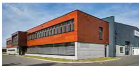
Passivhaus und Sitz eines Herstellers von Passivhaus-Komponenten in Reinsdorf/Sachsen
