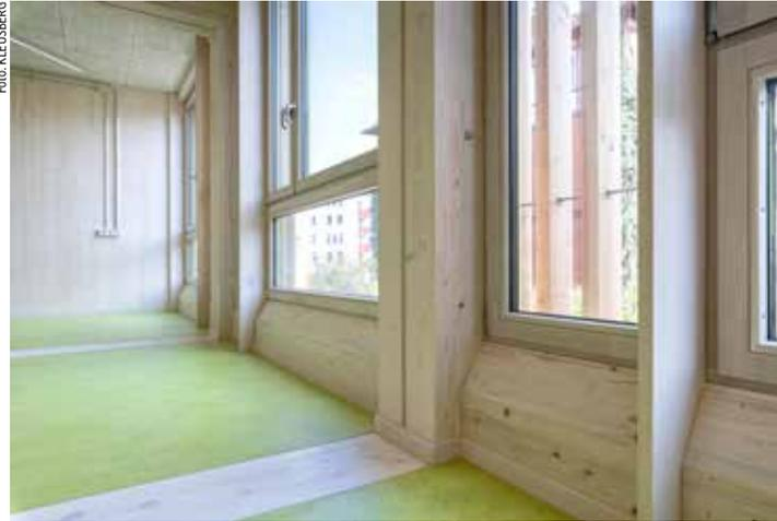
**Das Modulbauunternehmen realisierte bereits einige Schulprojekte in modularer Stahlskelettbauweise, bei diesem sollte eine Massivholzkonstruktion verwendet werden**
