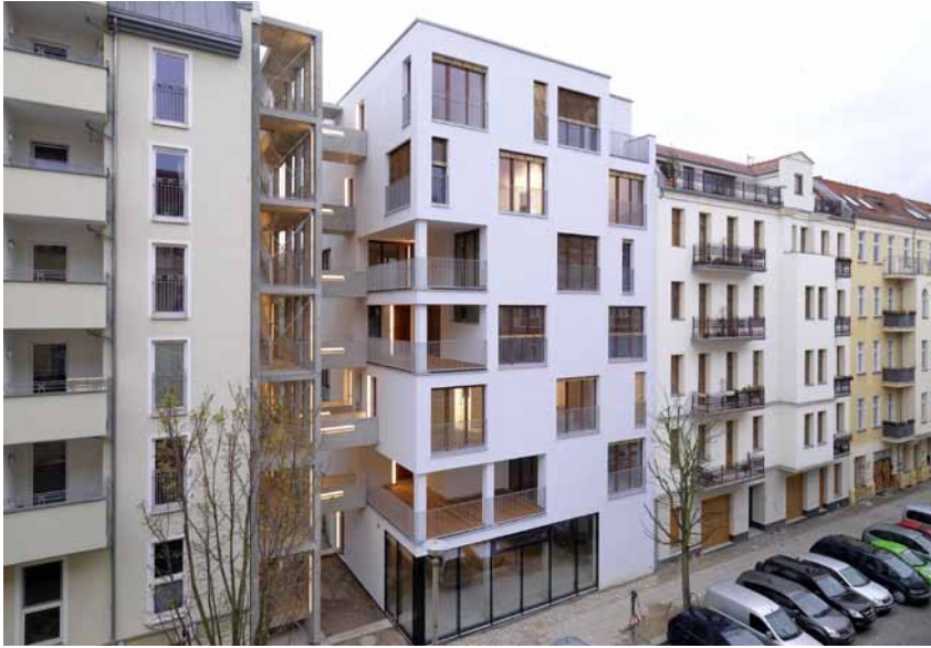
Das erste innerstädtische Holzhaus dieser Größe – ein siebengeschossiges Gebäude im Zentrum von Berlin
