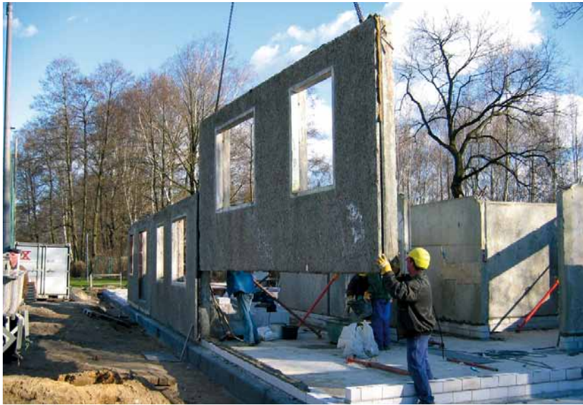
Rückgebaute Plattenbauteile wiederverwenden – das ist das Ziel der Fachgruppe »Bauliches Recycling« in der BTU Cottbus
