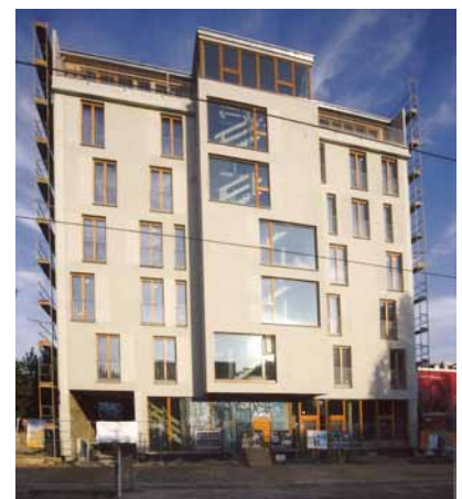
Kombiniert auf innovative Weise bewährte und neue Technologien: der Passivhaus-Neubau der Leuchtturm eG in Berlin
