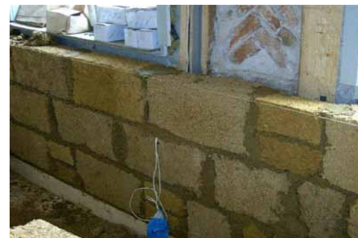
Innendämmung mit Holzleichtlehmsteinen
