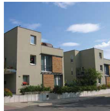
Neubau von Stadtvillen aus gebrauchten Betonelemente am Standort Cottbus
