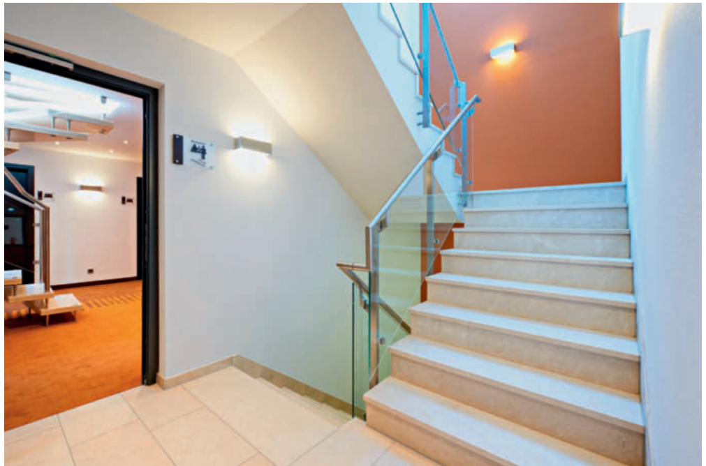
Kann kein zweiter Rettungsweg aus einer Nutzungseinheit mit einem Aufenthaltsraum gestellt werden, schreibt der Gesetzgeber sogenannte Sicherheitstreppenräume vor
