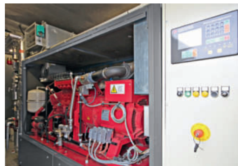
Wolf BHKW GTK 35 M mit 60 kW thermischer und 36 kW elektrischer Leistung
