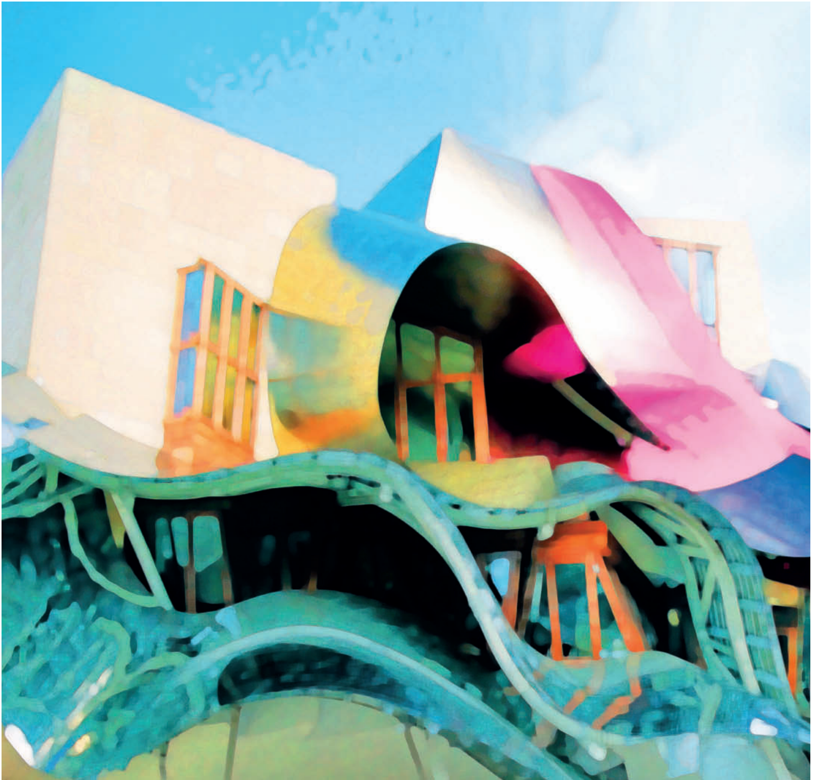
Marqués de Riscal, Elciego/Rioja, Spanien Architekt: Frank O. Gehry, Gehry Partners, LLP, Los Angeles
