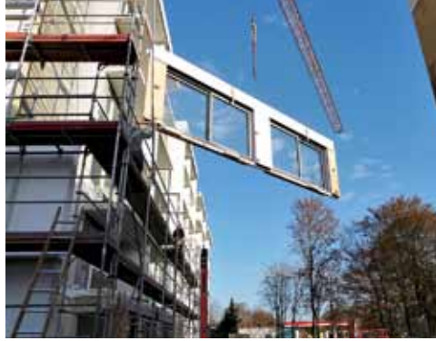
Die fertigen Fassadenelemente werden mit dem Kran in Position gehoben
