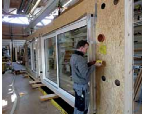
Bei der Produktion der Fassadenelemente werden alle Durchdringungen luftdicht abgeklebt
