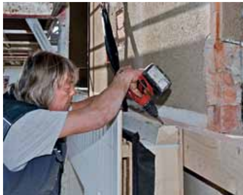
Der Anschluss an die Bestandswand erfolgt über vormontierte Bauchbinden
