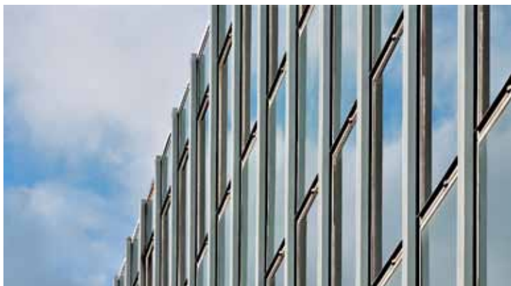
Fassade mit opaken Brüstungspaneelen
