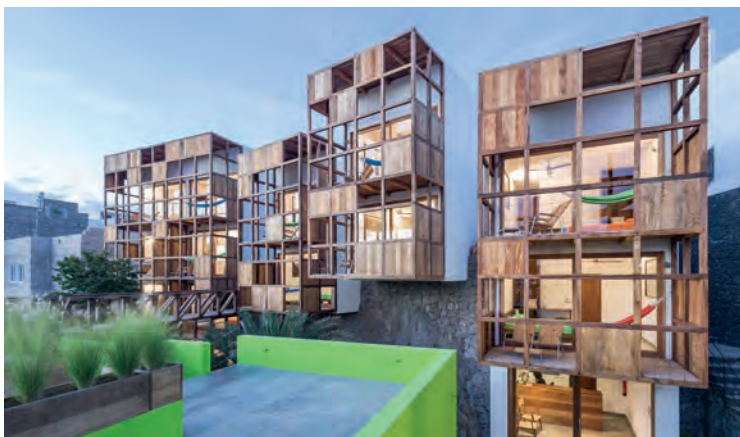
Das Dach des Altbaus und die Hotelzimmer sind über eine Brücke verbunden
