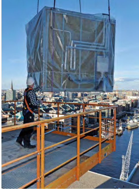
Foto: Schwörer Bauindustrie
