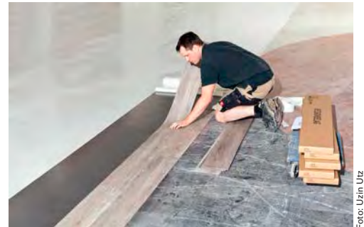
Einen neuen Belag ohne größeren Nutzungsausfall zu verlegen, ist nur möglich, indem dieser auf den bereits vorhandenen Belag verlegt wird
