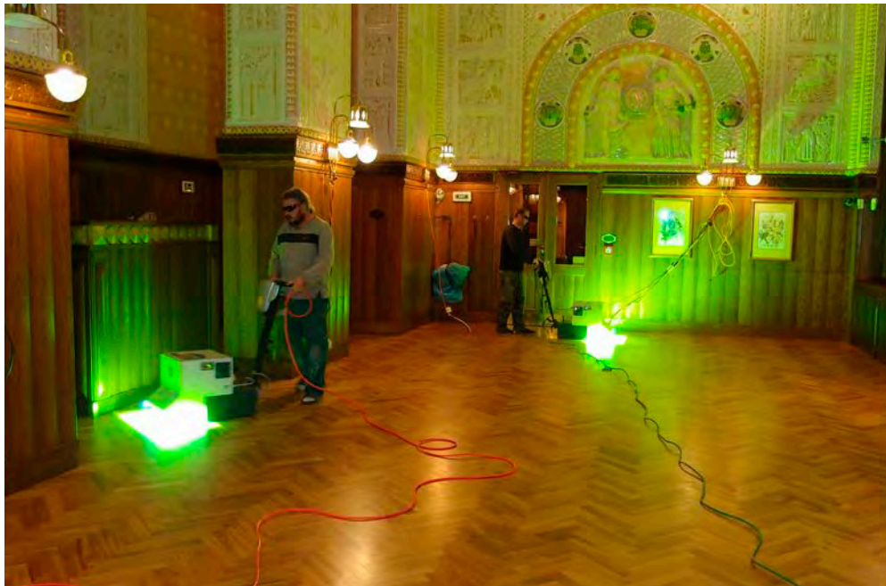
Aushärtung mithilfe von ultraviolettem Licht macht den Parkettboden sofort nach der Versiegelung voll nutzbar. Lange Trocknungszeit und Nutzungsausfall nach der Oberflächenrenovierung entfallen
