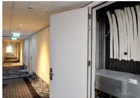
Für die Installation von VRF-Systemen wird nur wenig Platz benötigt
