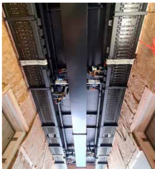
Foto: Kaufmann Bausysteme
